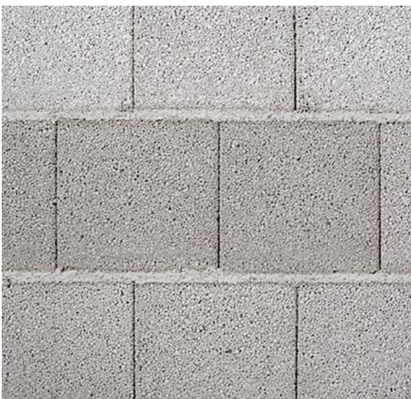
Liapor-Mauersteine sind 5-seitig geschlossen und werden mit den offenen Kammern bzw. Schlitzen nach unten verlegt. Der abschließende Deckel der Steinoberfläche verhindert das Verfüllen dieser Öffnungen mit Mörtel. Dadurch wird Mörtel eingespart und die wärmedämmtechnischen Eigenschaften werden nicht verschlechtert.
